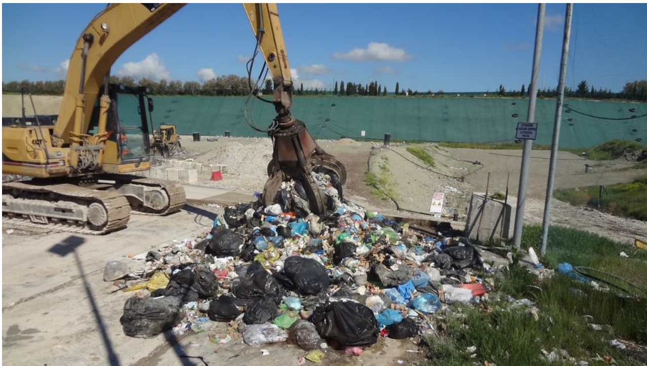
Figura 36. operazioni di quartatura del campione
