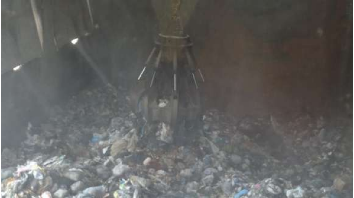
Vasca di accumulo dei rifiuti prima del vaglio meccanico presso impianto TMB
