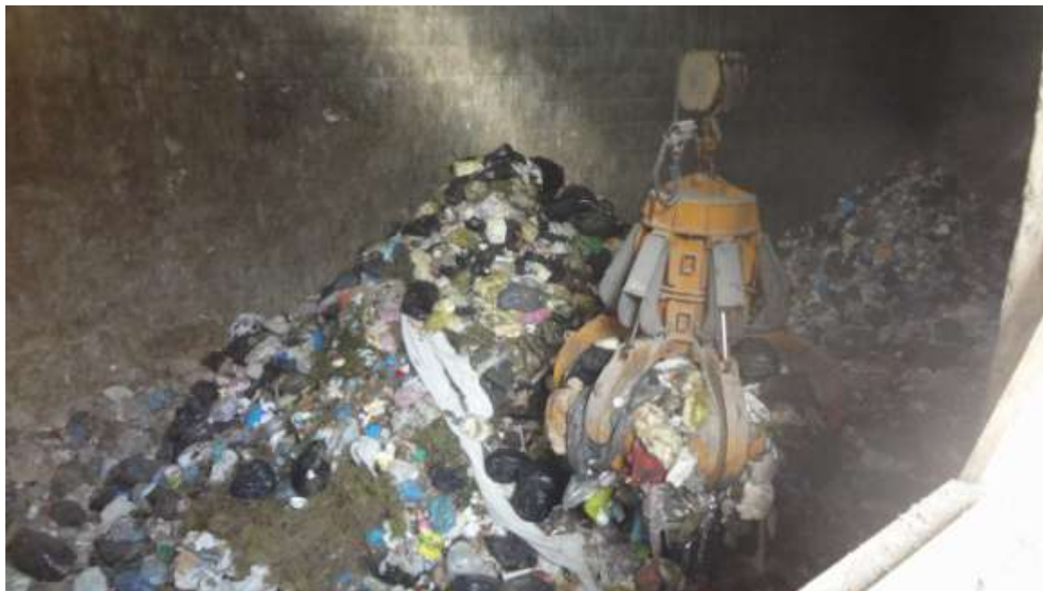
Vasca di accumulo dei rifiuti prima del vaglio meccanico presso impianto TMB
