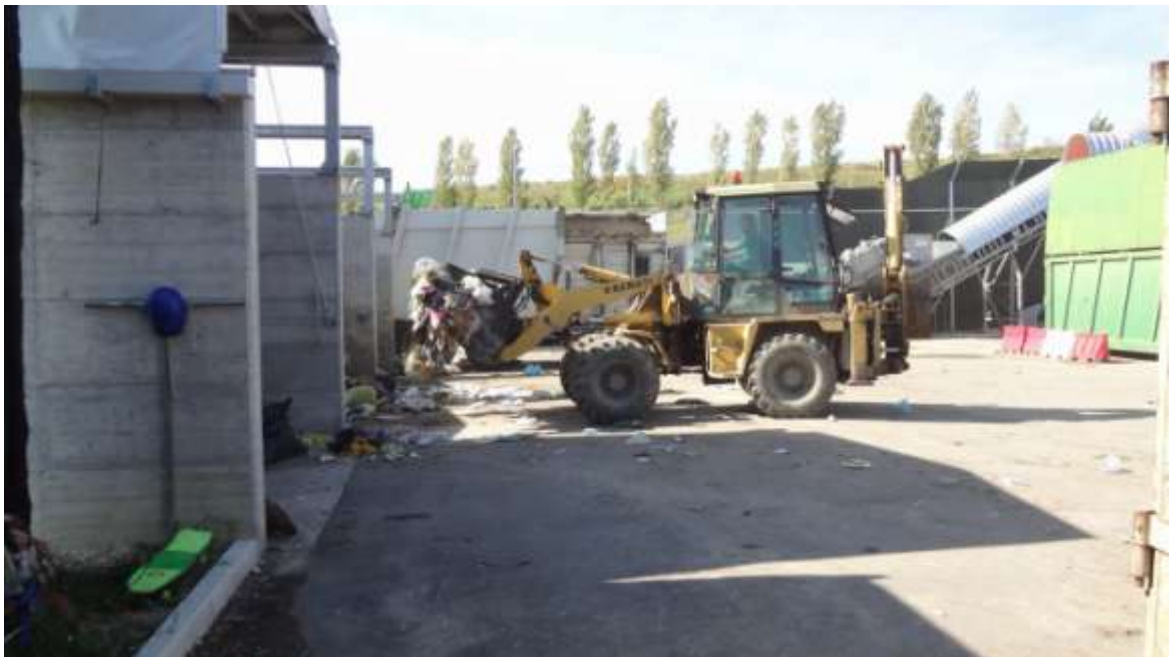
Operazioni di quartatura tramite pala gommata
